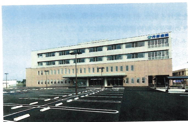
写真 1 丹野病院外観
